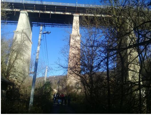
5 міст-плотина. Ам.100 Ат.180 міст відремонтували
