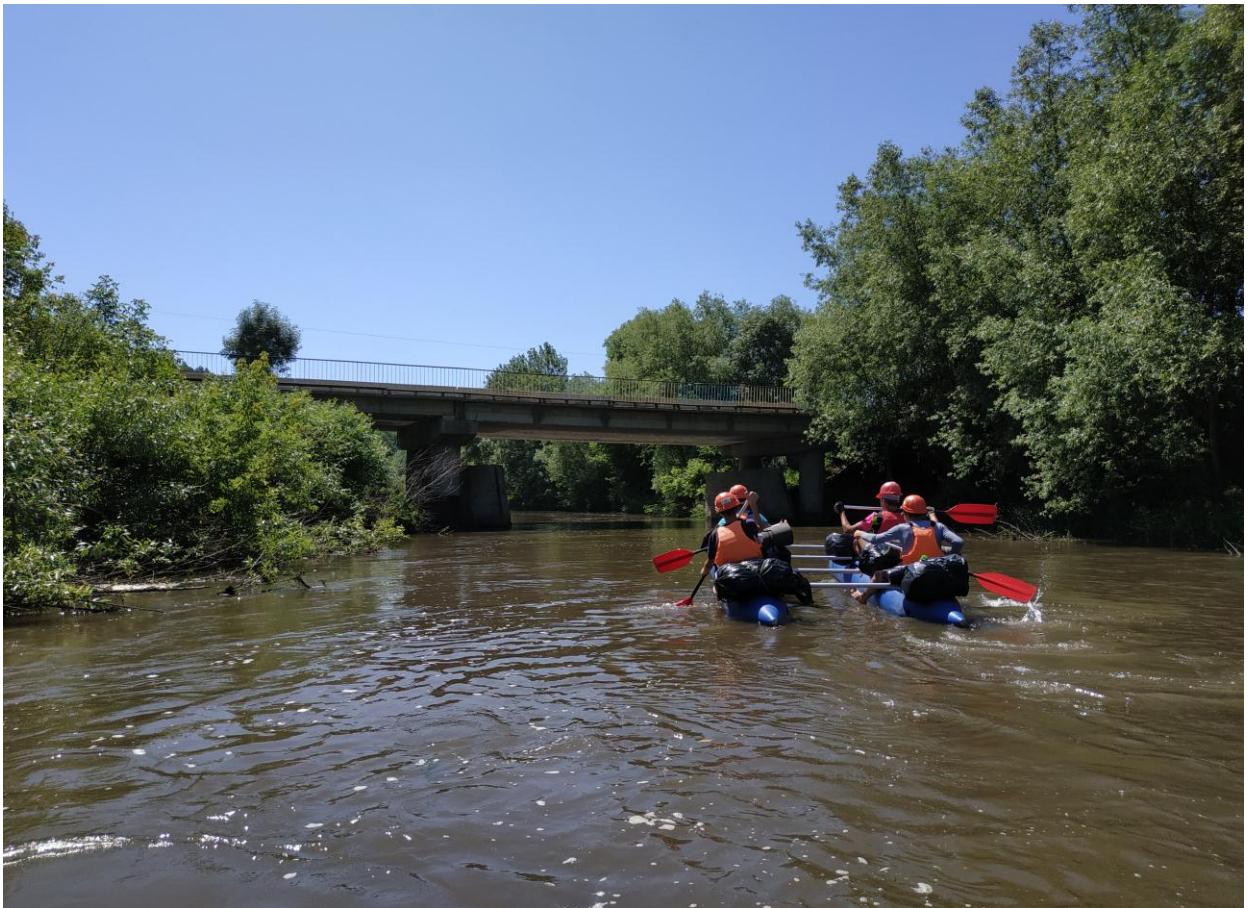
Фото 3. Автодорожній міст в с. Угринь
