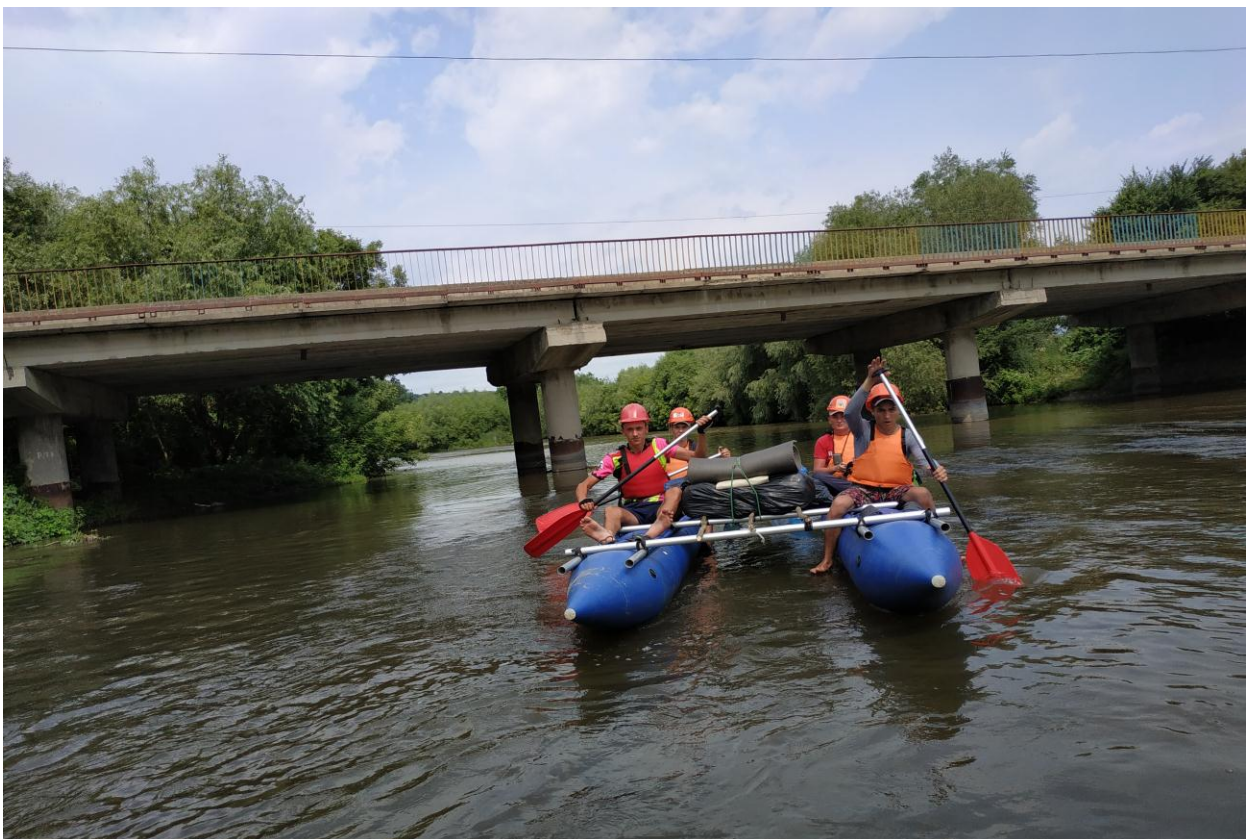
Фото 10. Дорожній міст в с. Олексинці
